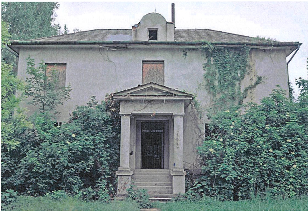
Főbejárati – északi – homlokzat
