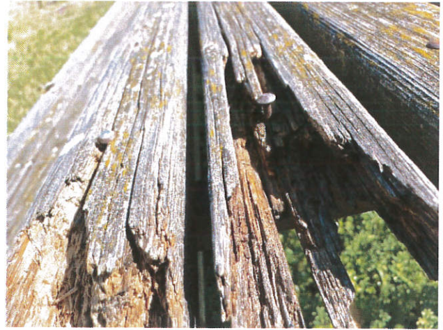
8-as fénykép: A padlórészek szépmálló általános állapoti jellege / kötőelemek állapota (példa)
