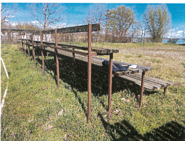
5-ös fénykép: A vázrész kiviteli és az egyes ülőszintek kiviteli jellege
