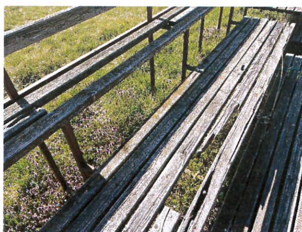
6-os fénykép: A padlórészek hiányos állapotú jellege (példa)
