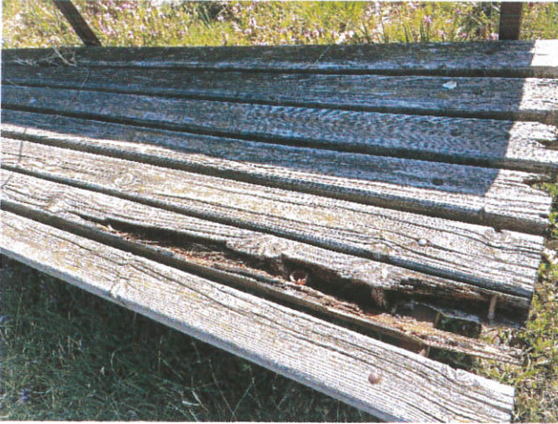
7-es fénykép: A padlórészek szépmálló általános állapoti jellege (példa)
